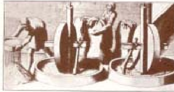
Mittelalterlicher Mahlgang
